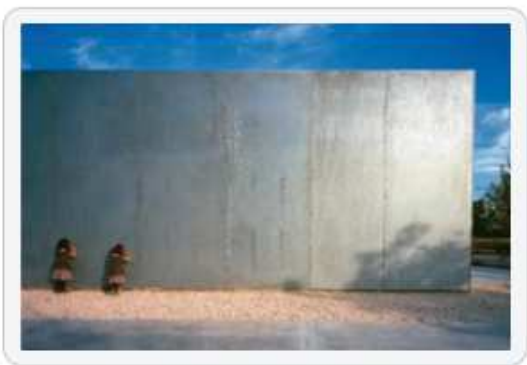
Chemielager der Universität Alcalá mit feuerverzinkter Blechfassade
