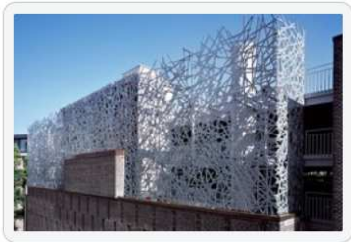
Salvatorgarage in München mit feuerverzinkter Fassade
