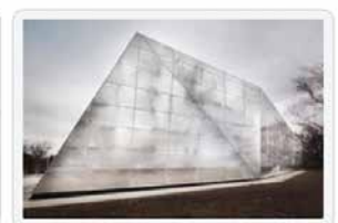
Supermarkt in Graz mit feuerverzinkter Blechfassade
