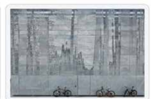
Stenenschool Dänemark mit bildgebender, gelochter Blechfassade aus feuerverzinktem Stahl
