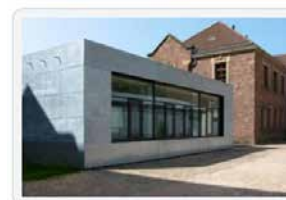
Druck- und Versandzentrum des LZD Karlsruhe mit feuerverzinkter Blechfassade
