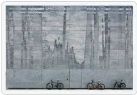
Sternenschule Dänemark mit bildgebender, gelochter Blechfassade aus feuerverzinktem Stahl
