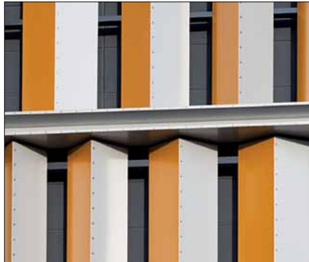
4 Aluminium-Fassade mit feuerverzinkter Tragkonstruktion
