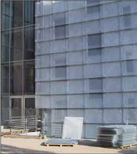
1 Feuerverzinkte Schuppenfassade aus Streckmetall
