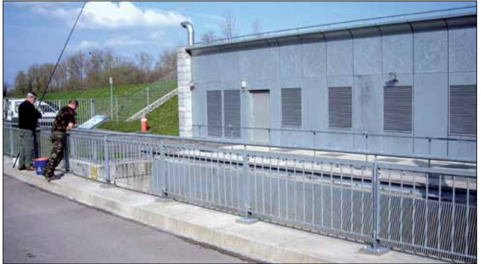
2 Fassade aus feuerverzinkten Blechen
