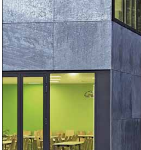
2 S. 4: Kubus mit feuerverzinkter Stahlfassade
