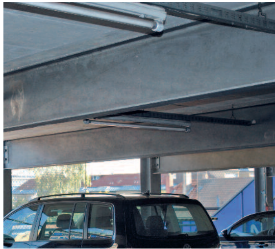
➔ Wartungsfrei: Feuerverzinkter Stahl im Parkhausbau
