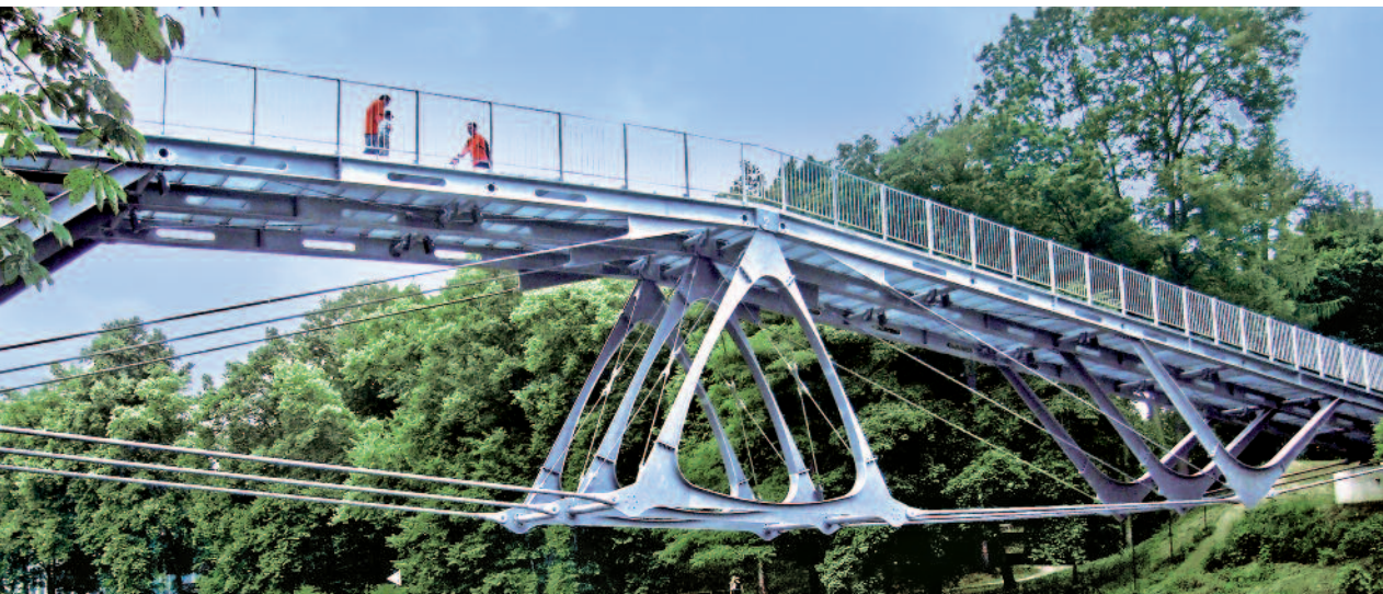
➔ Feuerverzinkte Brücke, Königgrätz (Architekten: baum & baroš Architekten, Roetgen/Aachen)
