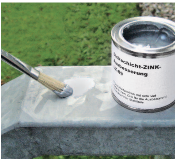
➔ Zinkstaubbeschichtungen sind zur Ausbesserung von Fehlstellen im Zinküberzug geeignet.
