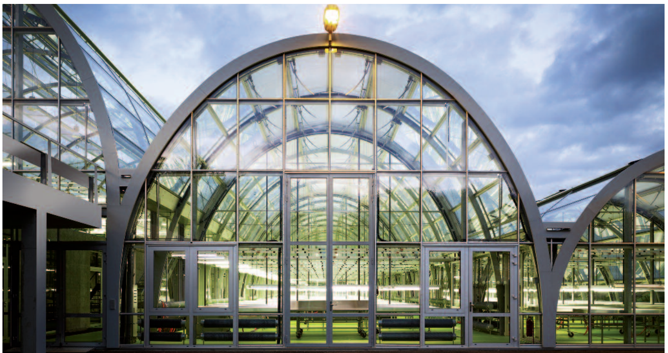
➔ Stückverzinktes Forschungsgewächshaus Campus Riedberg, Frankfurt (Architekten: Königs Architekten, Köln)
