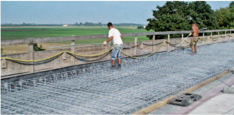
→ Feuerverzinkte Bewehrung einer Brückenkappe an der A99
