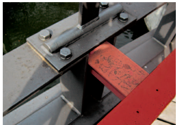
➔ Detailfotos einer Inspektion der Beschichtung nach 27 Jahren.
