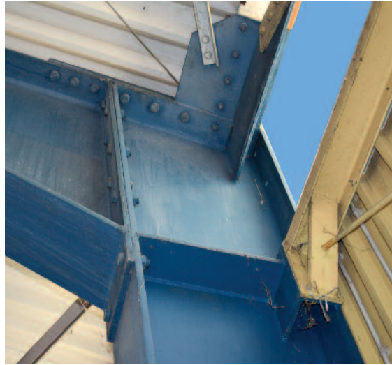
Fotos einer Inspektion des Duplex-Systems der Kunsteisbahn Balingen nach 41 Jahren.
