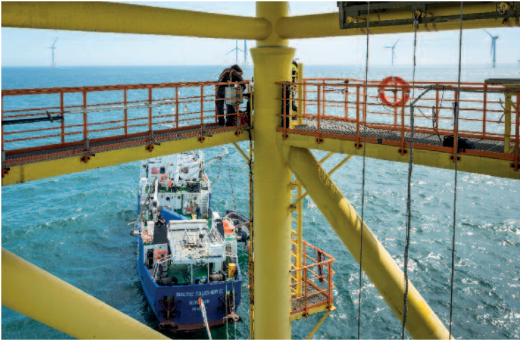
➔ Die duplex-beschichteten Bauteile der Offshore-Forschungsstation Fino 1 sind nach 10 Jahren mängelfrei, während die nur beschichteten Stahlbauteile Korrosionserscheinungen aufweisen. (Fotos: Holger Vonderlind)
