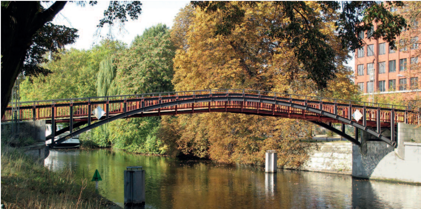
➔ Duplex-beschichtete Fußgängerbrücke Hiroshimasteg
