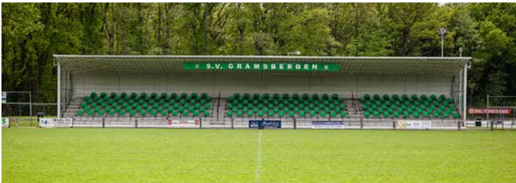
Links Bereit für einen weiteren Lebensabschnitt: Die feuerverzinkte Stahlkonstruktion der wiederverwendeten Tribüne hat das Potenzial 100 Jahre alt zu werden
